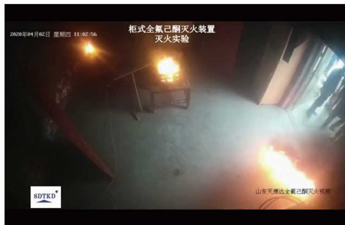
柜式全氟己酮灭火装置模拟火灾灭火实验现场照片
